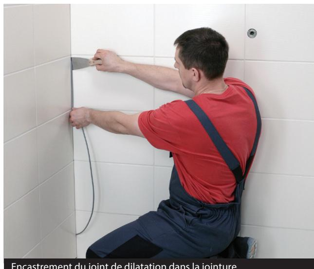
Encastrement du joint de dilatation dans la jointure
