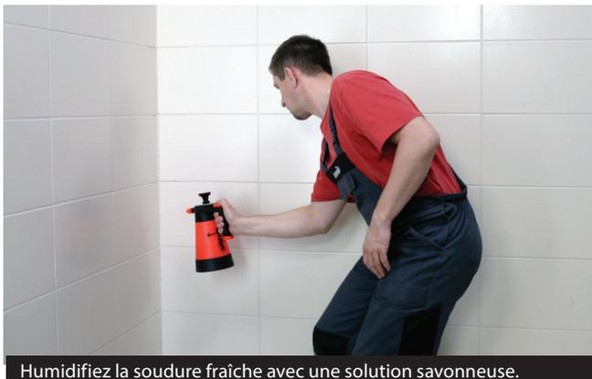
Humidifiez la soudure fraîche avec une solution savonneuse.
