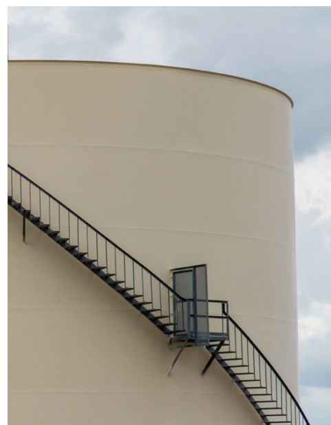
Rezervoari za vodu
