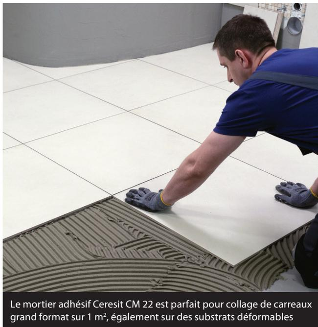
Le mortier adhésif Ceresit CM 22 est parfait pour collage de carreaux grand format sur 1 m<sup>2</sup>, également sur des substrats déformables
