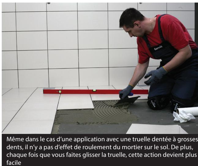
Même dans le cas d'une application avec une truelle dentée à grosses dents, il n'y a pas d'effet de roulement du mortier sur le sol. De plus, chaque fois que vous faites glisser la truelle, cette action devient plus facile
