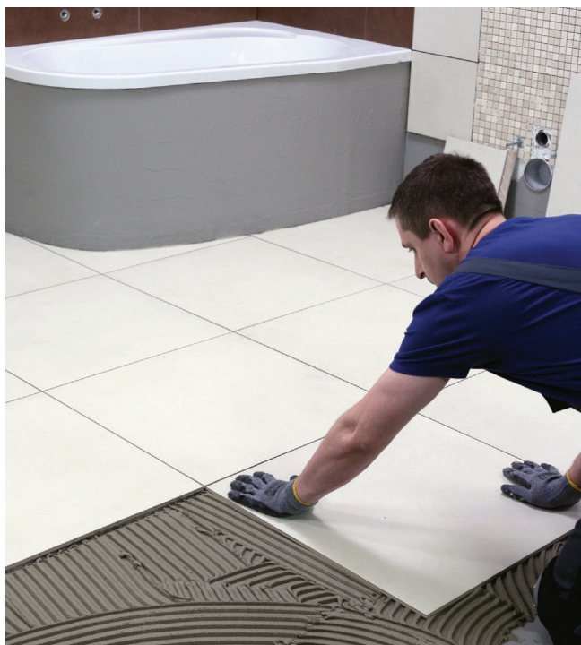
Zaprawa klejąca Ceresit CM 22 doskonale sprawdza się w przypadku klejenia płyt wielkoformatowych powyżej 1 m 2 , także na podłożach odkształcalnych
