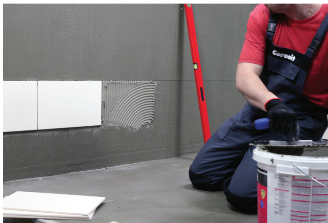
W przypadku powierzchni pionowych nie wymagane jest stosowanie np. listew startowych z uwagi na brak spływu
