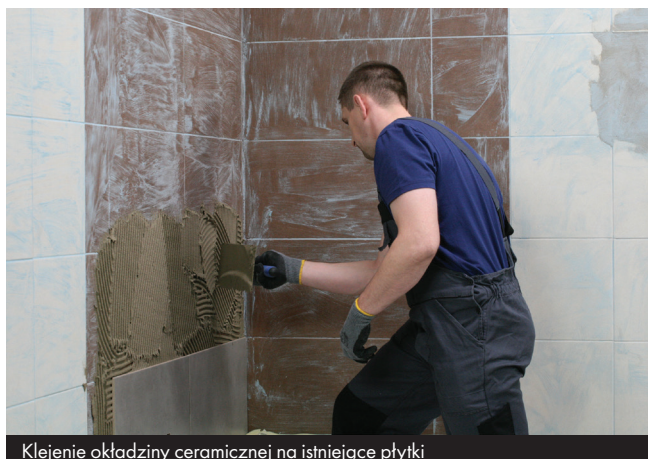
Klejenie okładziny ceramicznej na istniejące płytki
