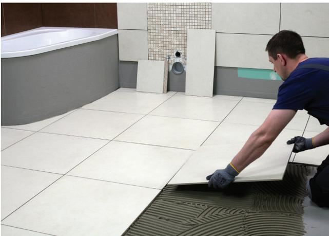
Grâce à l'utilisation d'une combinaison spéciale de charges, le mortier CM 11 PLUS est parfait pour coller des carreaux de grès
