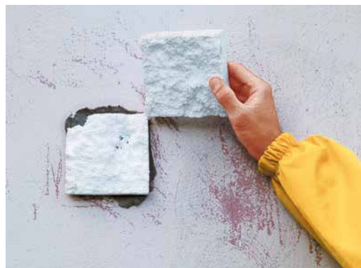
Otra pārbaudes metode jeb pull-off tests
