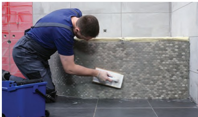
Palaukite. Glaisto formavimą atlikite apvaliais judesiais.
