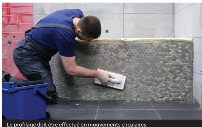
Le profilage doit être effectué en mouvements circulaires
