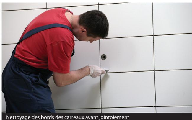
Nettoyage des bords des carreaux avant jointoiment
