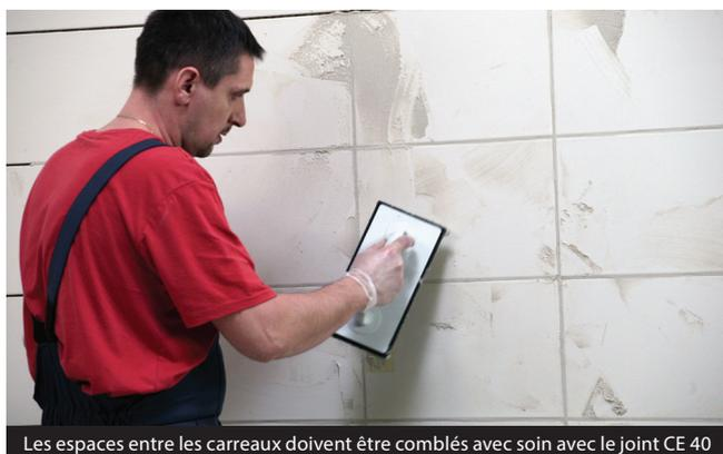
Les espaces entre les carreaux doivent être comblés avec soin avec le joint CE 40
