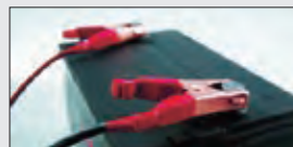
バッテリーケーブル固定
