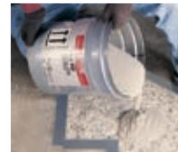
コテ塗布用で、コンクリート床面の補修、割れ表面の再仕上げ用です。新旧いずれのコンクリートにも優れた接着性を示し、また高い耐薬品性を有します。
