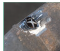
金網が補修部分を補強し、エポキシ補修剤の裏あてとなります。
