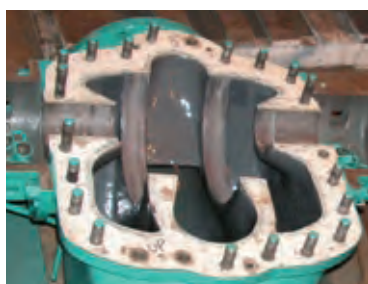
補修完了し再組み付け準備完了
