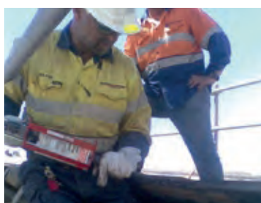
コンベヤーベルトは2時間で使用復旧に成功
