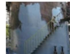
2液タイプのポリサルファイド変性エポキシ系の保護コーティング剤。鋼鉄やコンクリート表面への優れた接着性と環境腐食防止を目的として設計されており、最小限の表面処理で0.5mm厚まで塗布可能、柔軟でエラストマー性、クラックブリッジ、耐腐食性に優れます。
