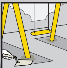
Postavljanje dečijeg igrališta
