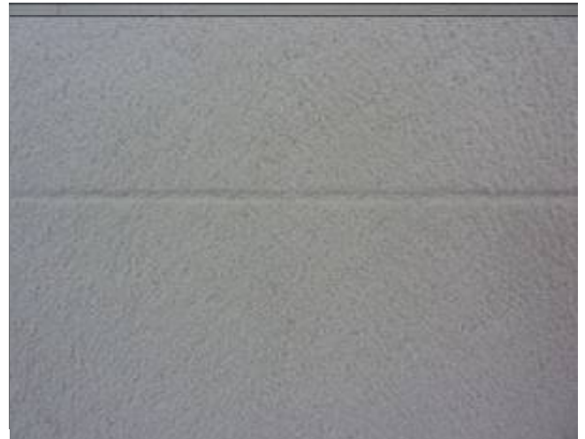
Рисунок 4.10 - Шаг 4. Разметка поверхности при помощи шнура на ширину применяемой матрицы (ширина «доски»).
