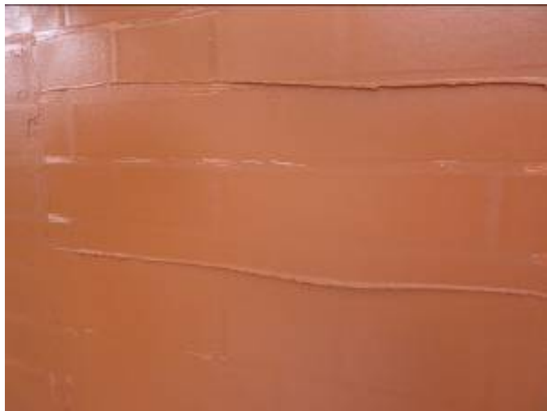
Рисунок 4.23 - Шаг 3. Загладить состав при помощи металлической терки.
