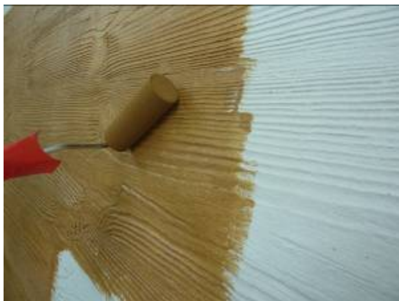
Рисунок 4.16 – Пример нанесения пропитки валиком.
