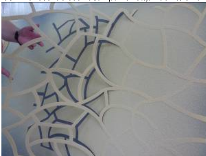
Рисунок 4.19 - Шаг 3. Снятие трафарета по свежему штукатурному составу.
