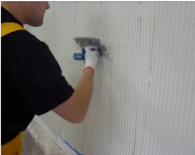
Рисунок 4.8. - Шаг 2. Нанесение при помощи зубчатой терки (зуб 8-10 мм)
