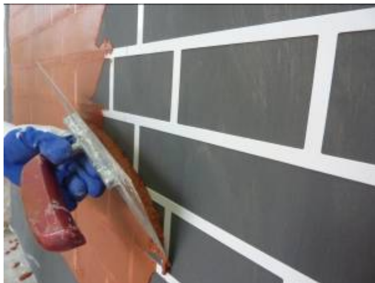
Рисунок 4.22 - Шаг 2. Нанесение декоративной штукатурки при помощи металлической терки.
