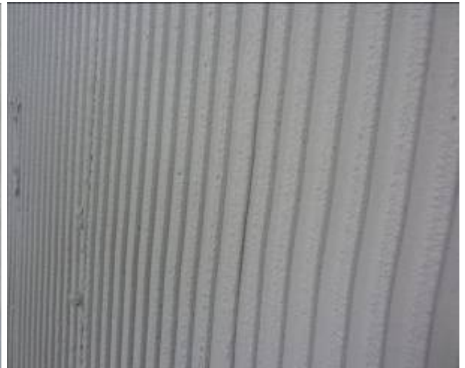
Рисунок 4.8. - Шаг 2. Нанесение при помощи зубчатой терки (зуб 8-10 мм)
