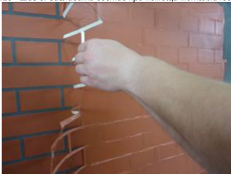
Рисунок 4.24 - Шаг 4. Снять трафарет по свежему штукатурному составу.
