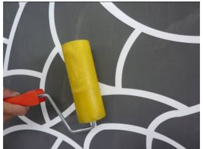
Рисунок 4.21 - Шаг 1. Наклеивание трафарета на обрабатываемую поверхность.
