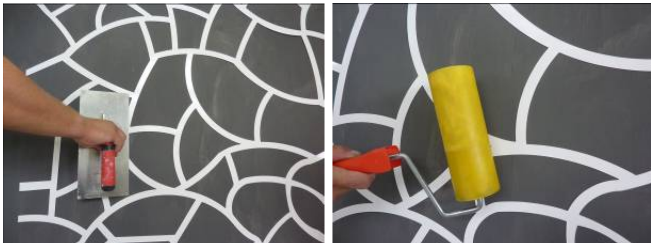
Рисунок 4.17. - Шаг 1. Наклеивание трафарета на обрабатываемую поверхность
