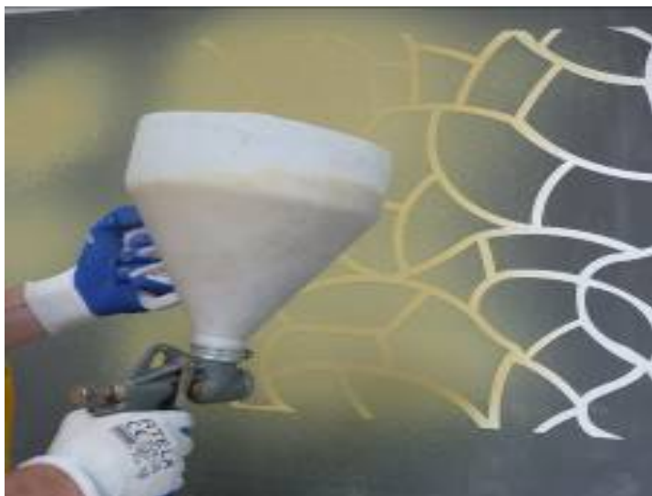
Рисунок 4.18 - Шаг2. Нанесение состава при помощи пистолета-пульверизатора.
