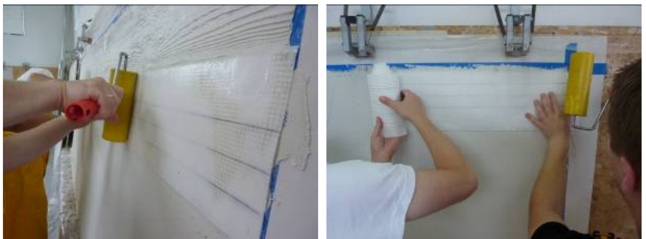
Рисунок 4.13 - Шаг 7. Раскатывание матрицы по свежему составу Ceresit СТ 36 и прижатие при помощи прокатного валика.
