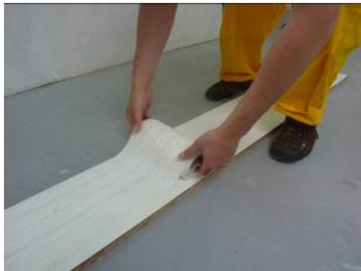
Рисунок 4.12 - Шаг 6. Сворачивание матрицы «под дерево» в рулон фактурной стороной наружу.
