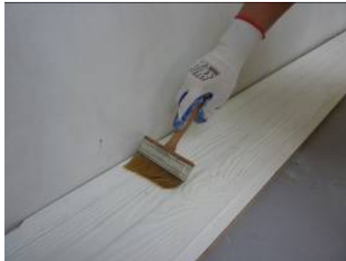
Рисунок 4.11 - Шаг 5. Подготовка матрицы «под дерево» к применению – обработка при помощи кисти-макловицы антиадгезионным составом Ceresit СТ 722.
