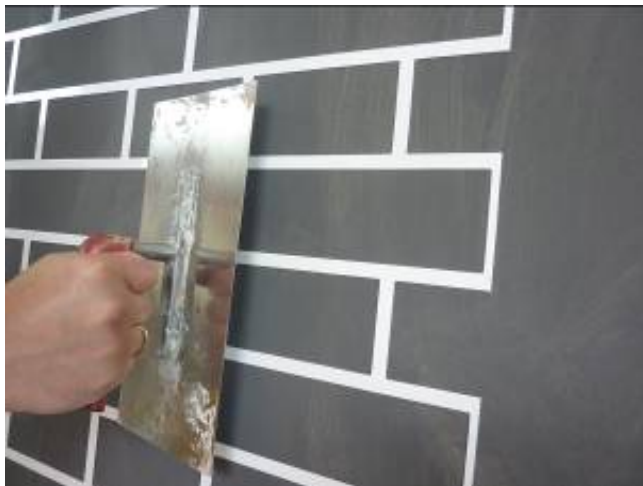
Рисунок 4.21 - Шаг 1. Наклеивание трафарета на обрабатываемую поверхность.
