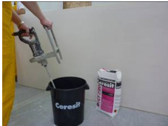
Рисунок 4.7. - Шаг 1. Подготовка состава
