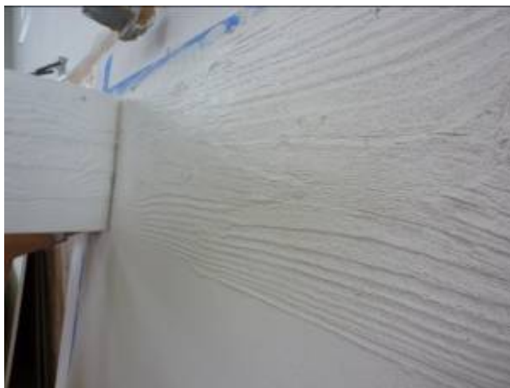
Рисунок 4.14. Шаг 8. Снятие матрицы после фактурирования состава Ceresit СТ 36.
