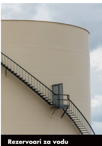
Rezervoari za vodu
