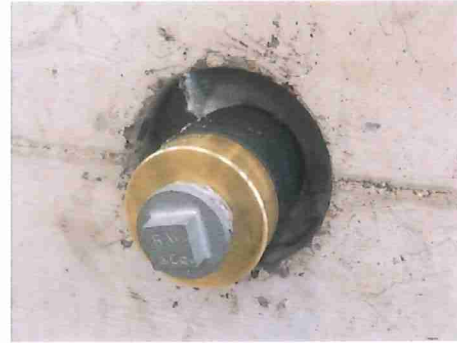
Ringraumverfüllung auf der zur Prüfglocke abgewandten Seite.
