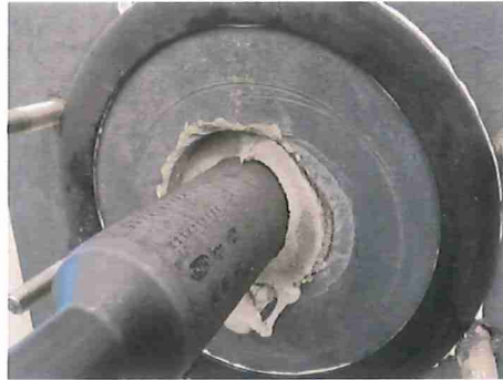
Ringraumverfüllung auf Seite der Prüfglocke.
