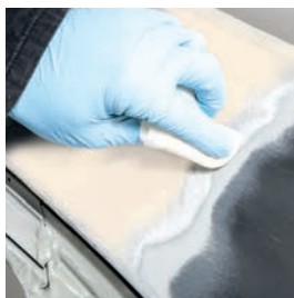
Aplikace utěrek BONDERITE M-NT 1455 W pouze na holý kov. Udržování vlhkého povrchu po dobu 2 min.
